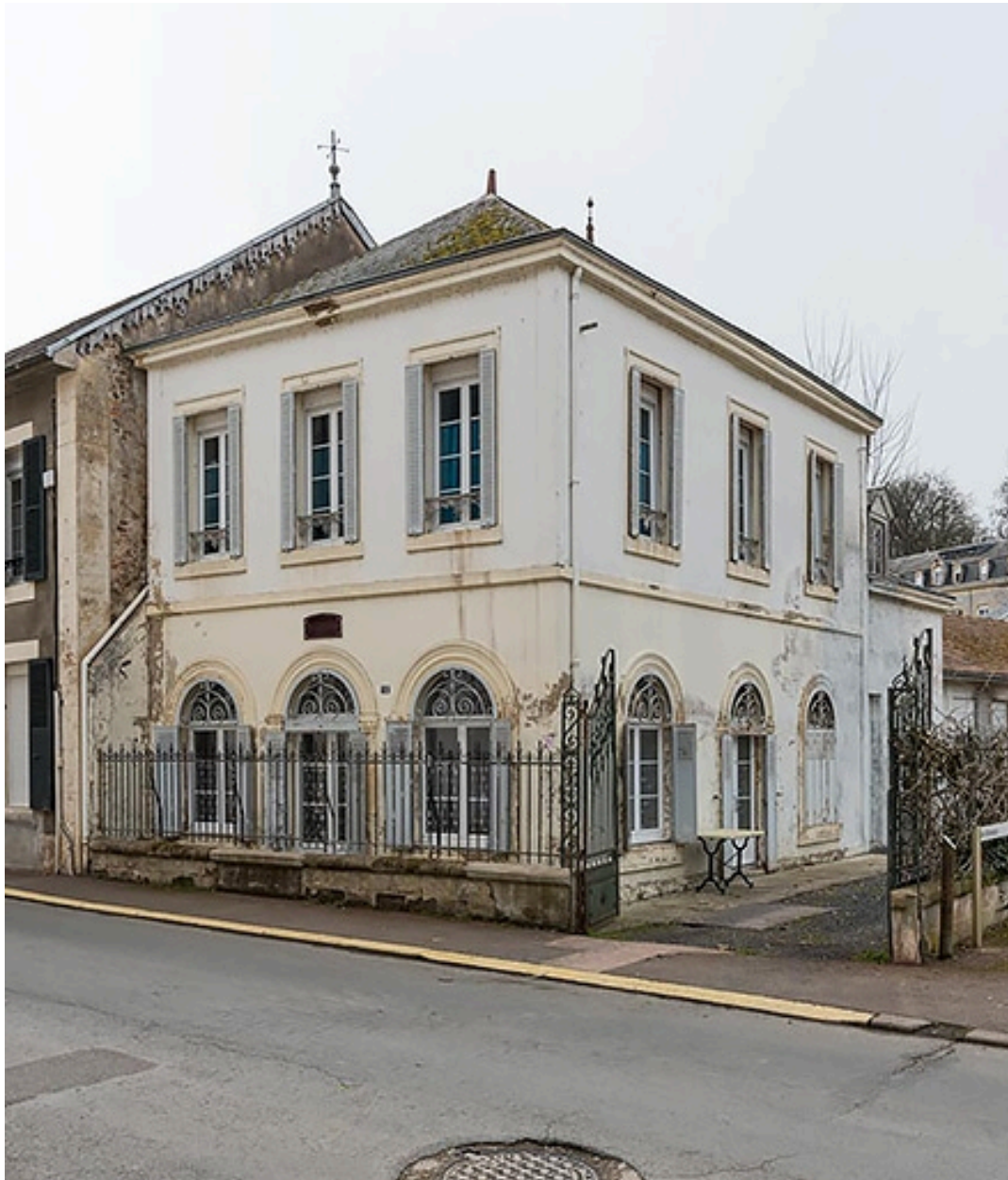
Façades sur l'avenue de la Libération.
