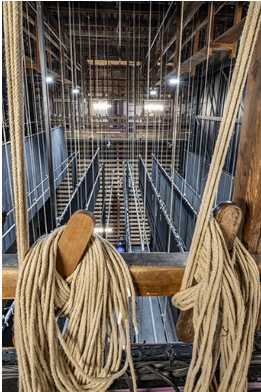
Cage de scène : cintres, vus de la passerelle côté cour, avec palets et fils au premier-plan.
