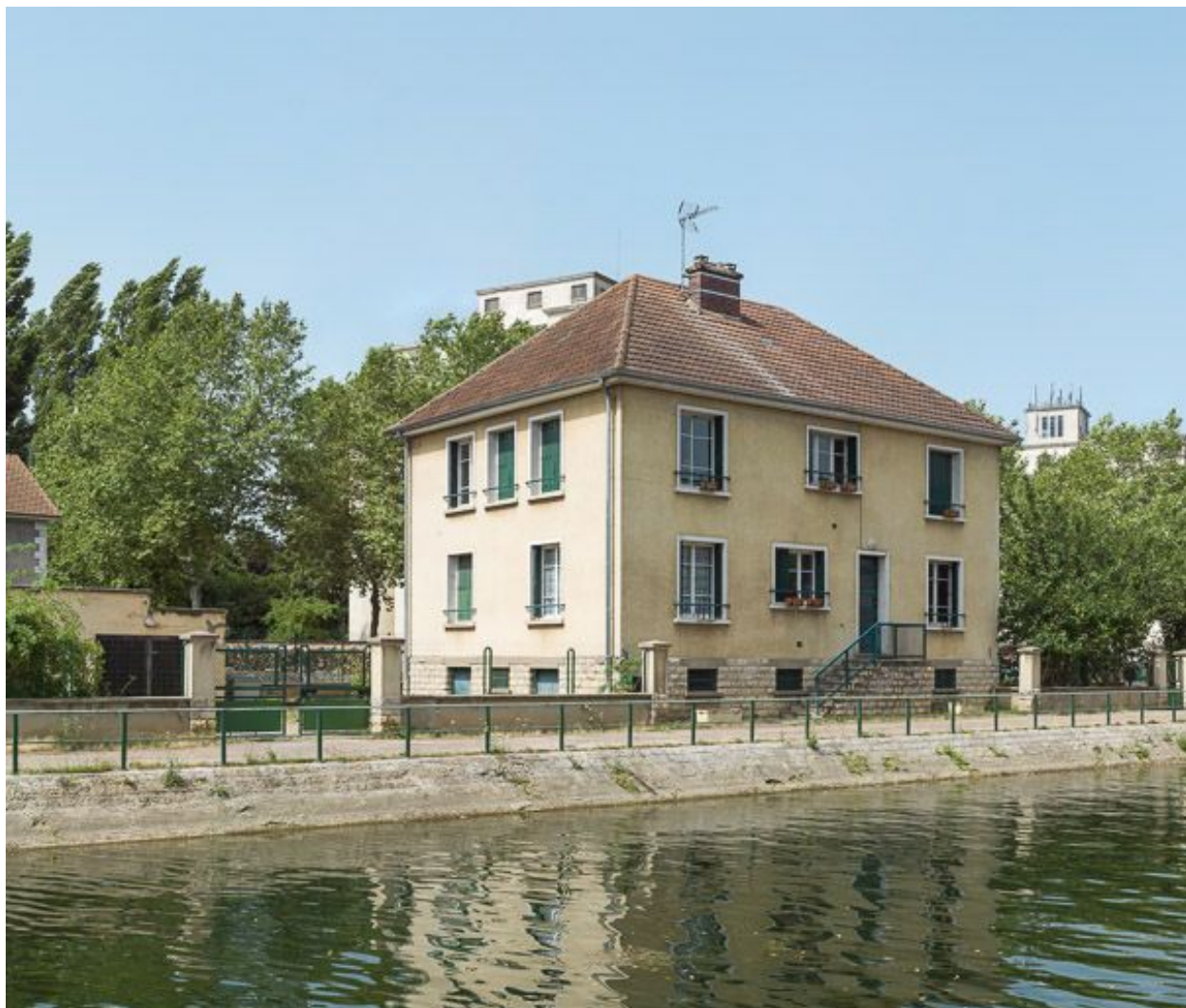
La maison éclusière, vue de 3/4.
