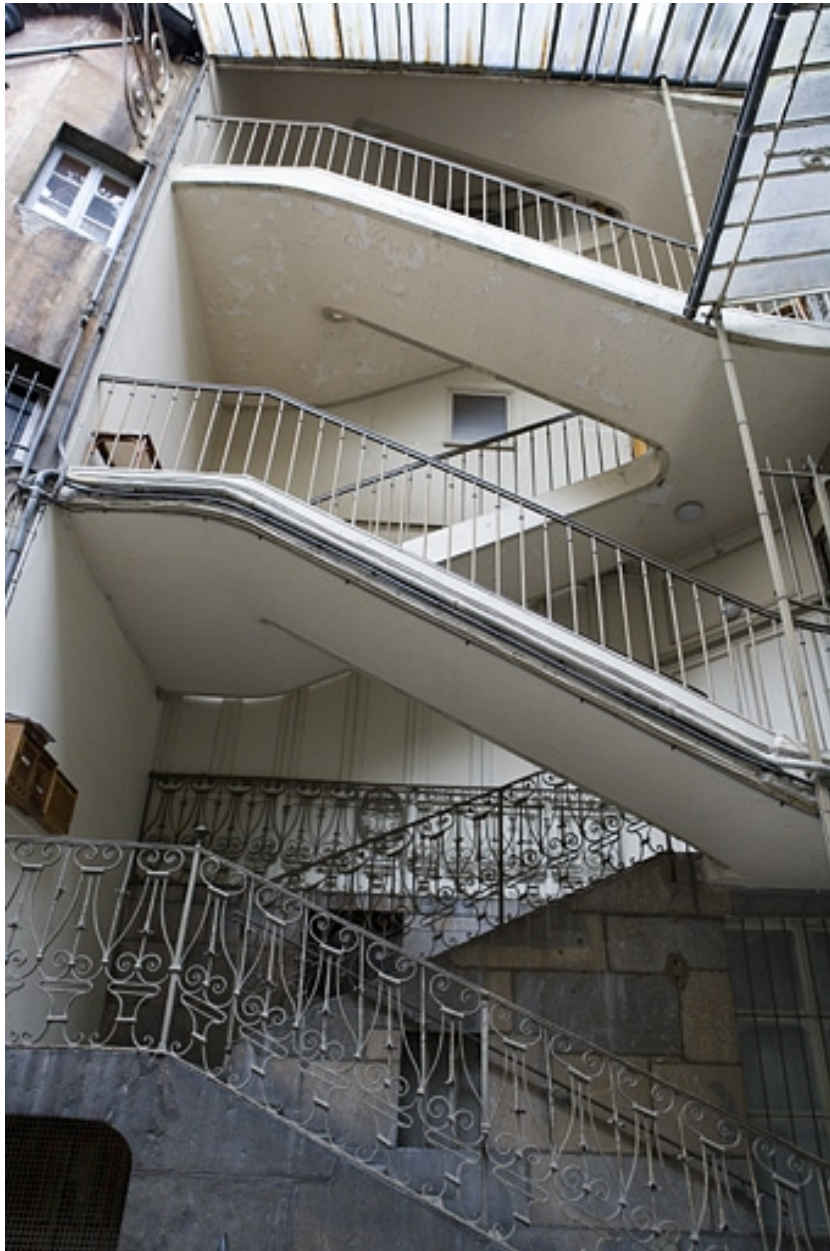
Vue d'ensemble de l'escalier à cage ouverte.
