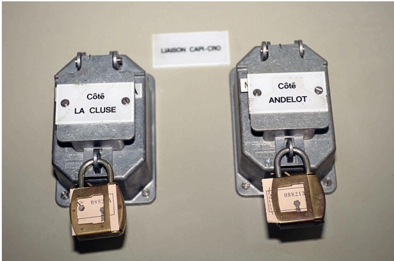
Commande manuelle du dispositif d'arrêt automatique des trains.
