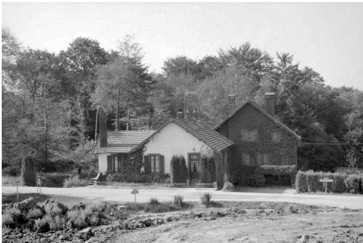
Logement d'ouvriers (Q, Q'), vu de l'est.
