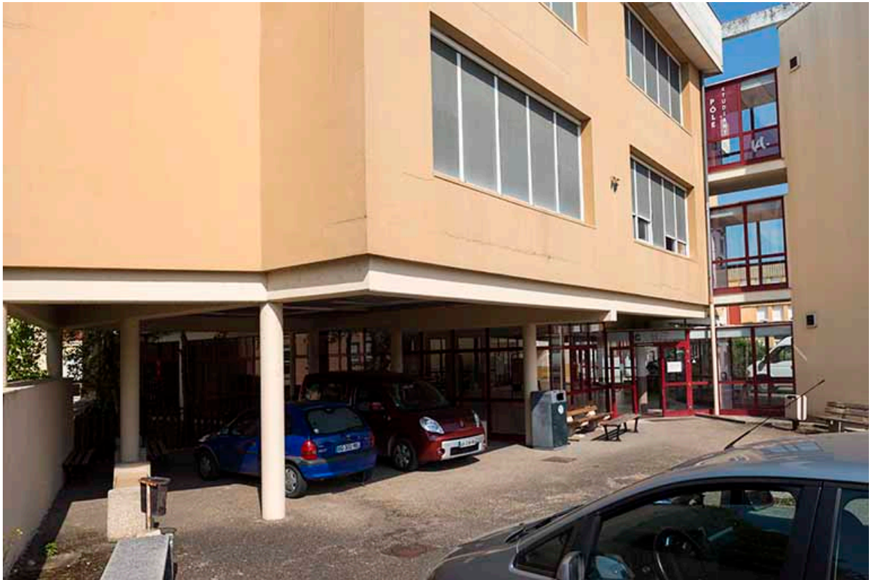
Détail du préau, au sud de l'externat ouest.
