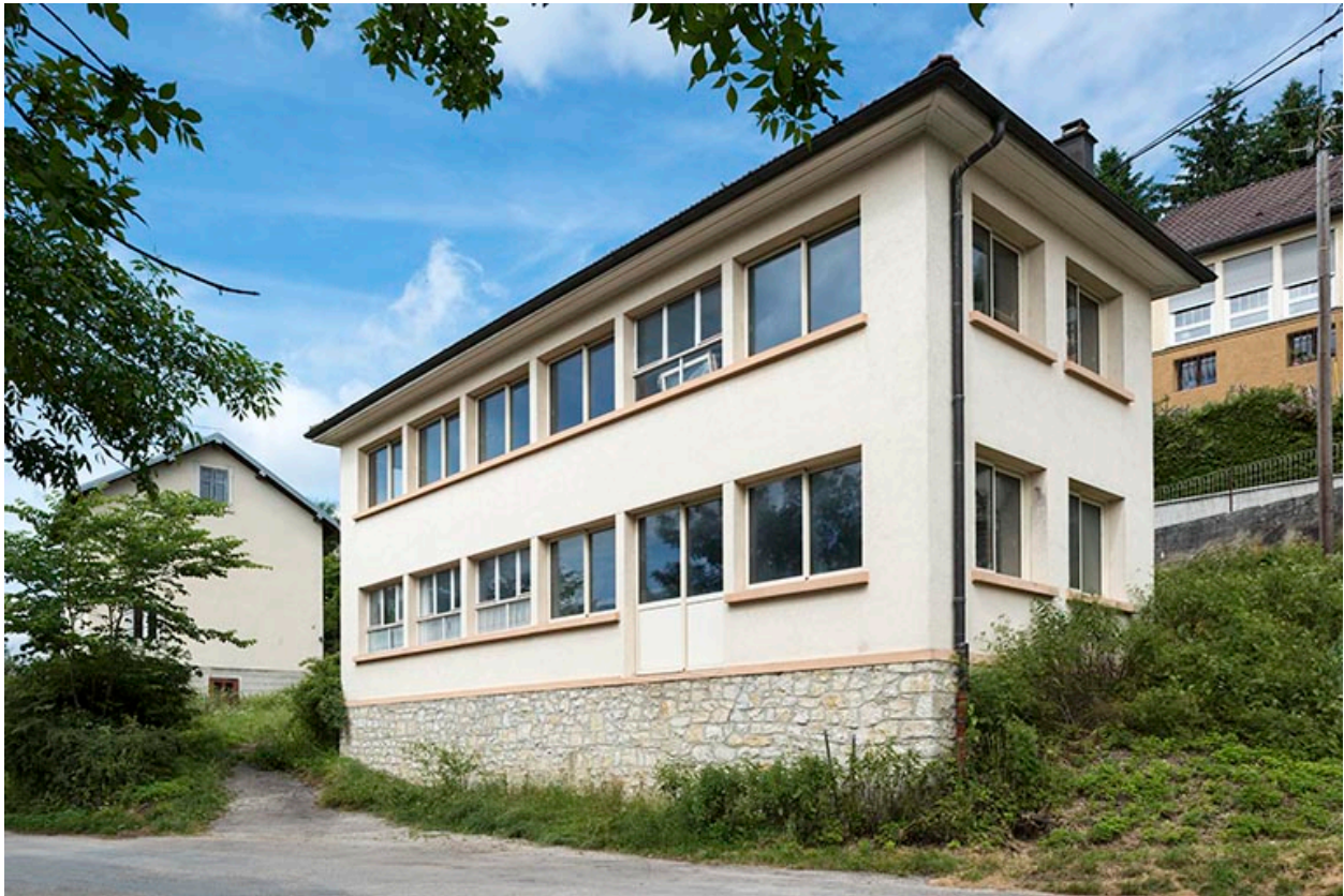
Usine d'outillage de la Manufacture d'Outillage d'Horlogerie Lerrac, Villers-le-Lac (Chaillexon).
