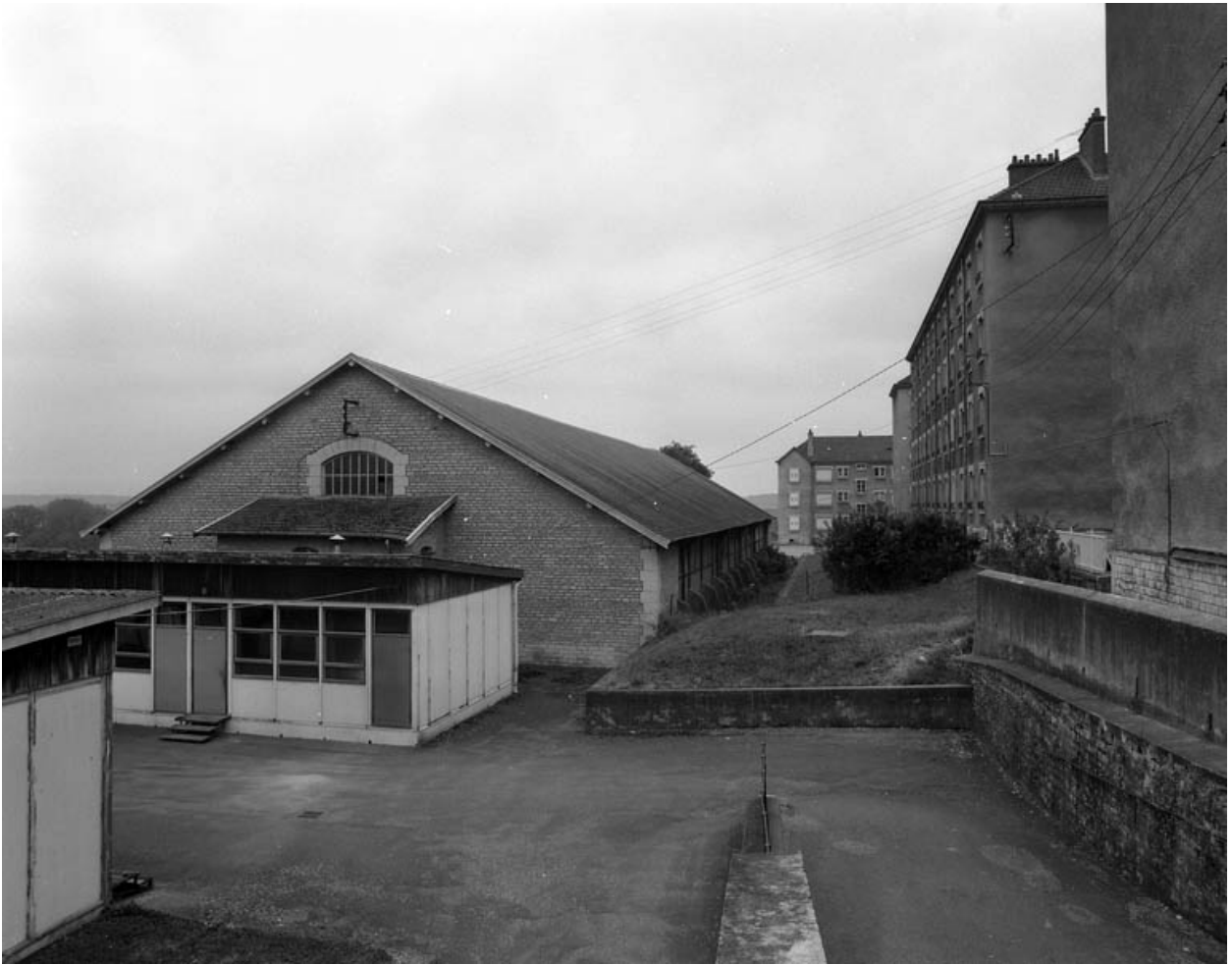
Le manège : façade postérieure de trois quarts droit.
