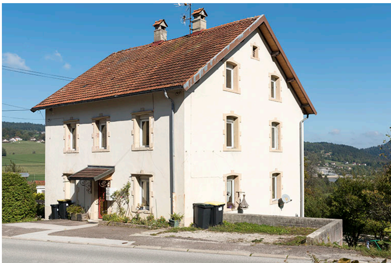
Façades antérieure et latérale droite.
