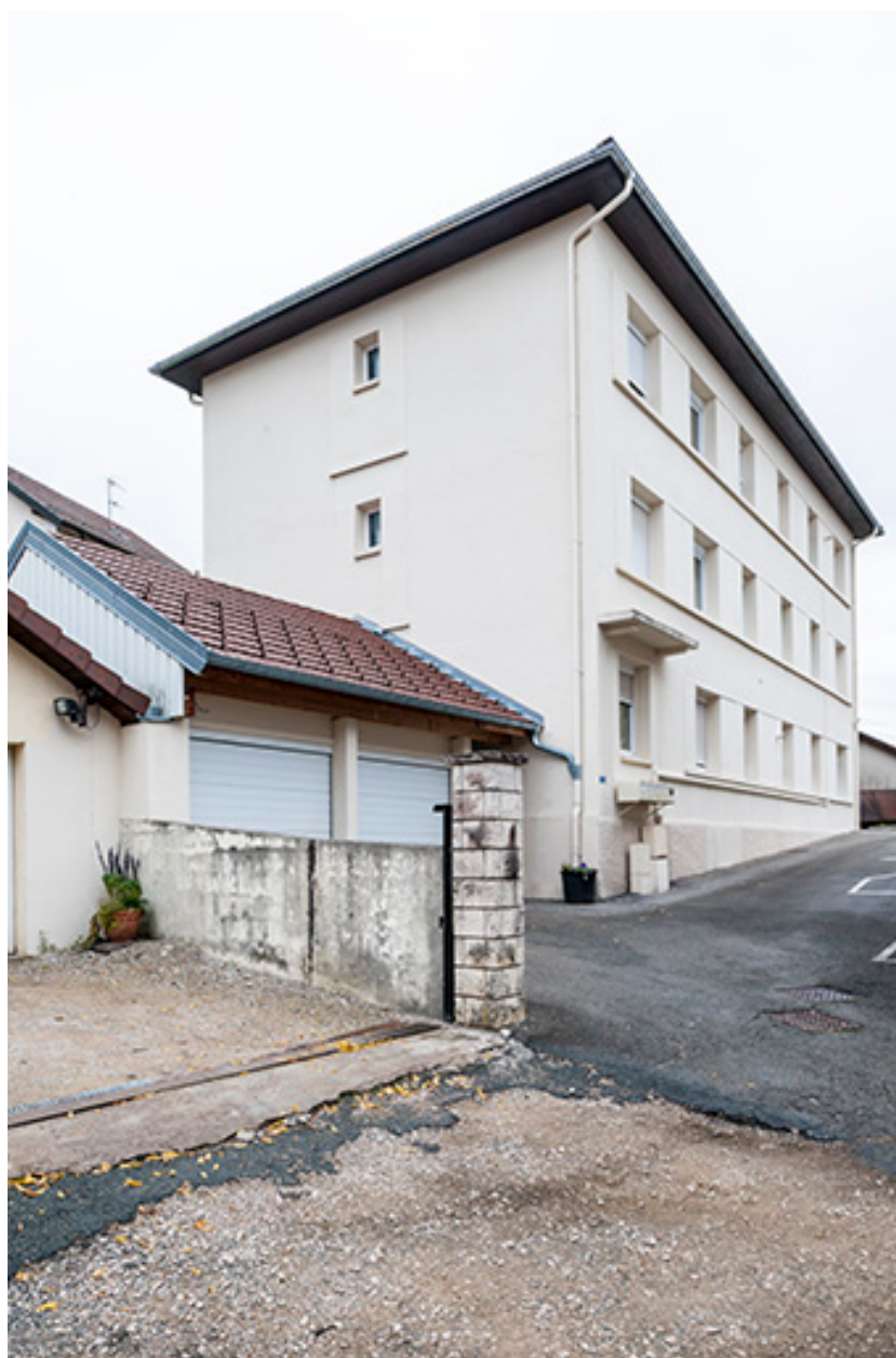
Usine : façades antérieure et latérale gauche.
