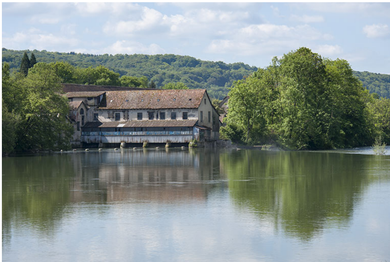
Bâtiment d'eau depuis l'amont.
