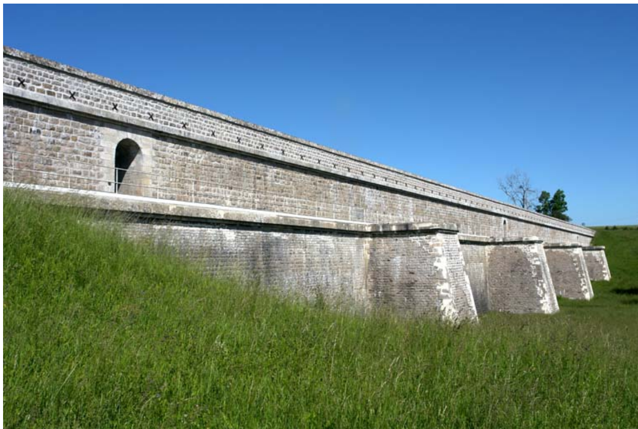
Face avant du barrage, vue d'ensemble.
