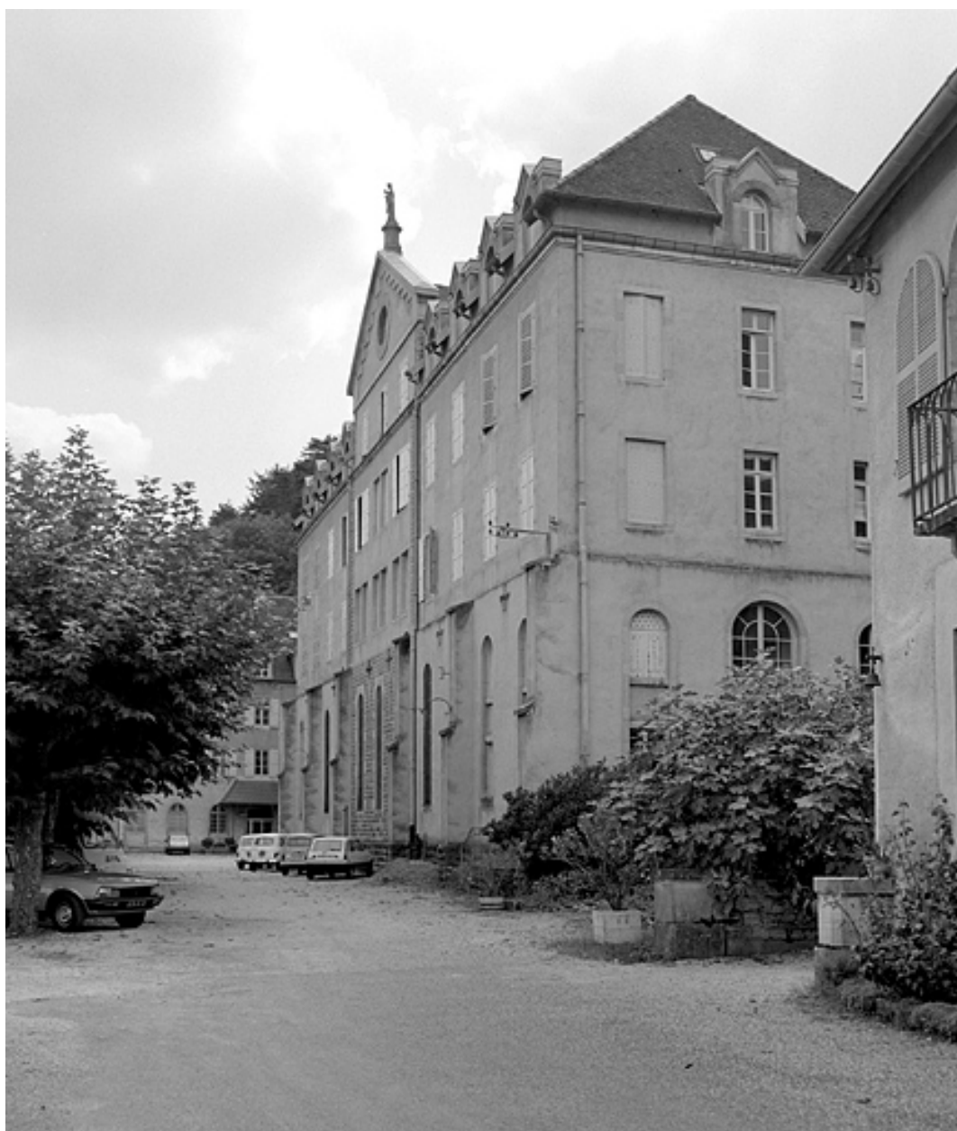
Vue de trois-quarts du bâtiment D.
