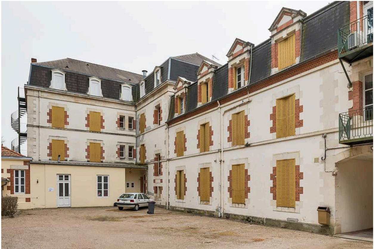
Façade sur la cour.
