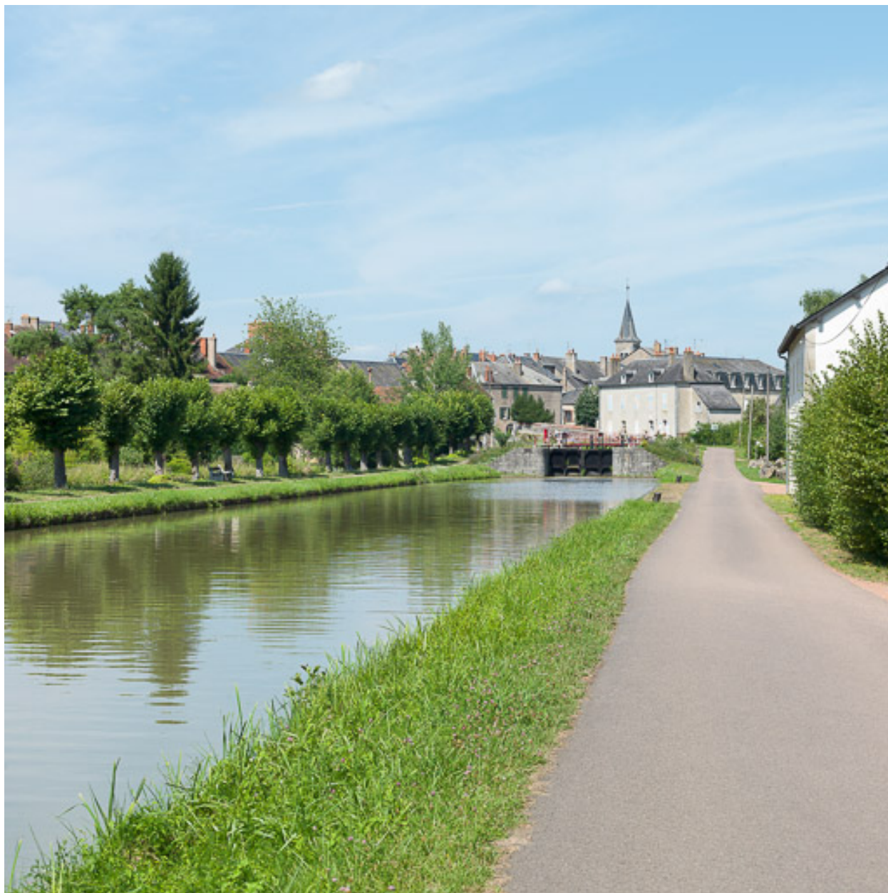
Vue du site d'écluse.
