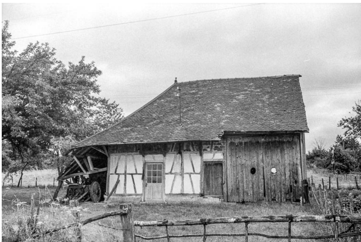
ferme cadastrée 1811 B 4 : vue générale.
