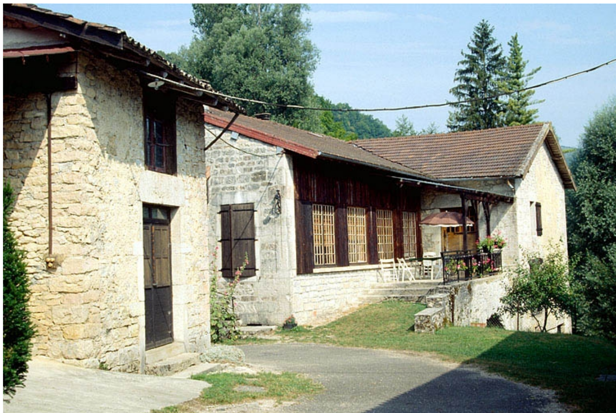
Façade postérieure du moulin et bâtiment (B).
