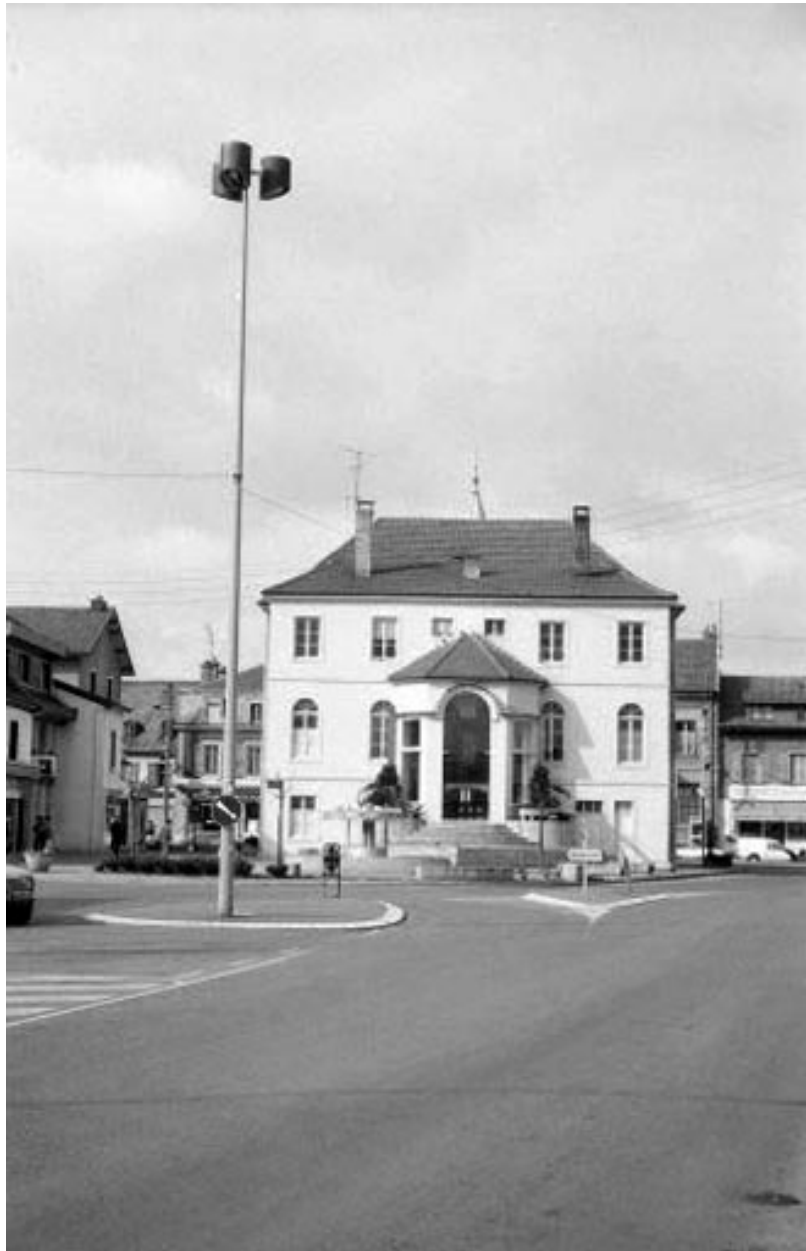
Vue de situation et façade postérieure.
