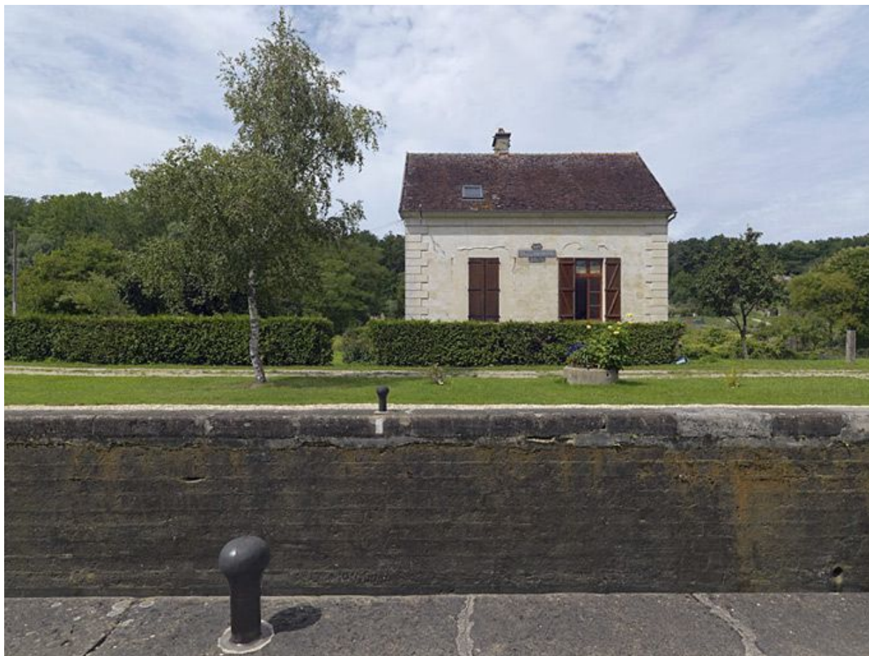
Maison éclusière : mur gouttereau sur canal.
