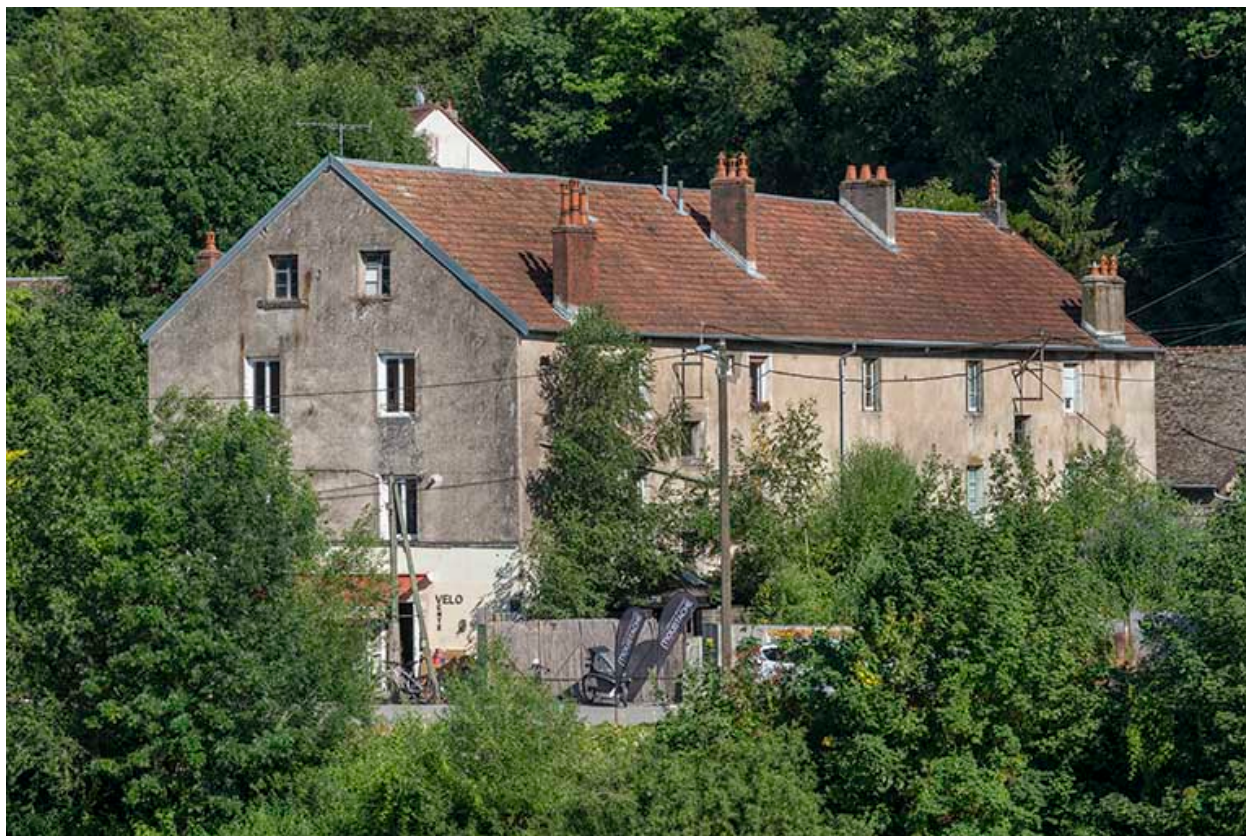
Logement ouvrier. Vue depuis le nord-ouest.
