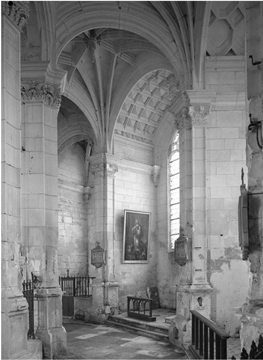
Côté gauche du déambulatoire, vue depuis la chapelle axiale.
