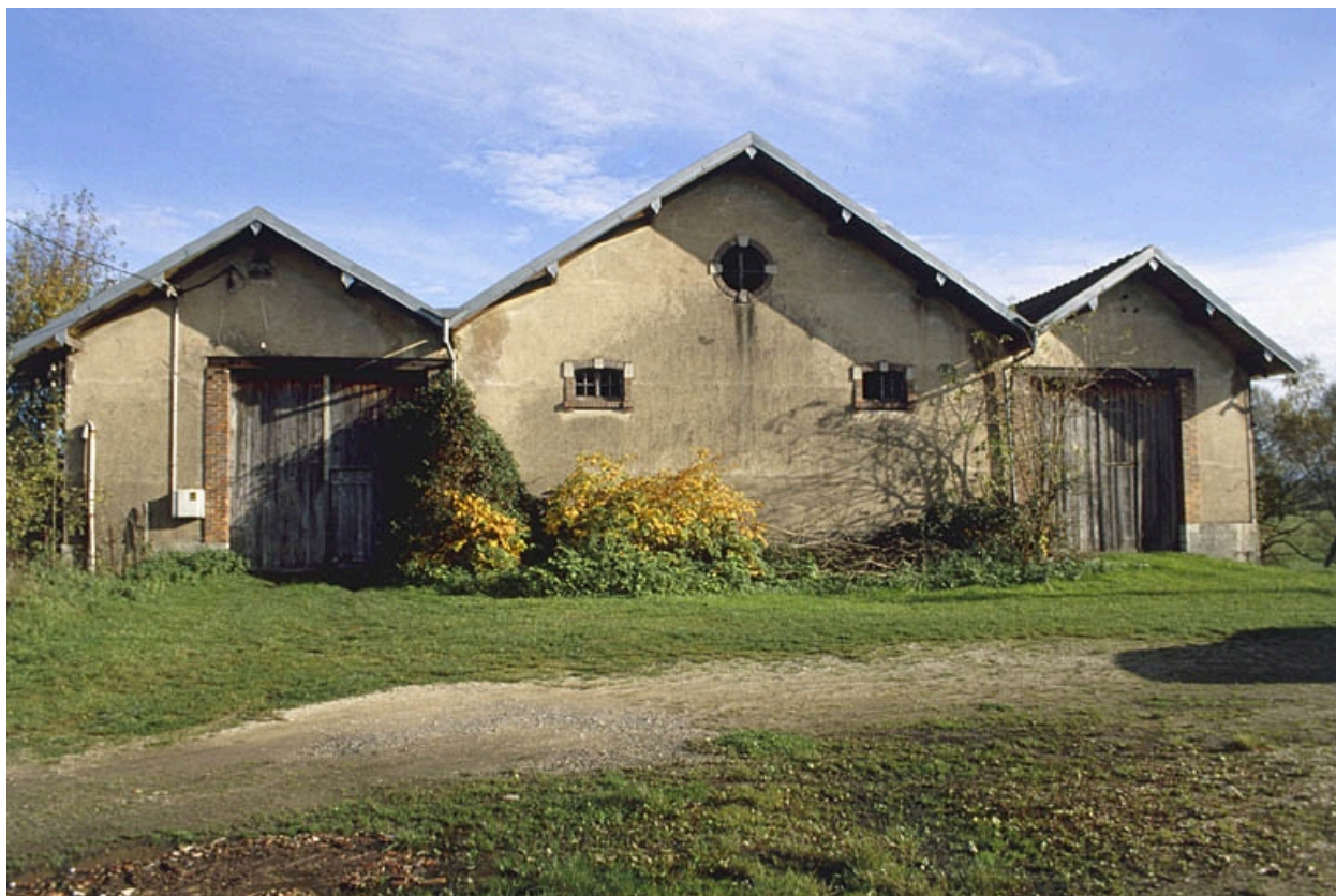
Murs-pignons du fenil.
