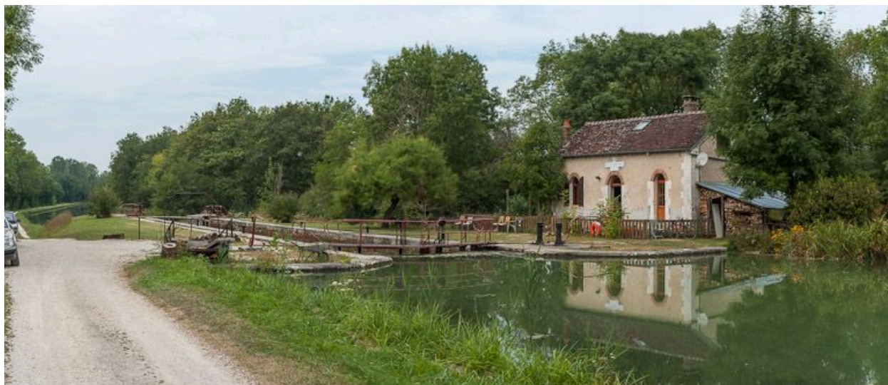
Vue d'ensemble du site d'écluse.
