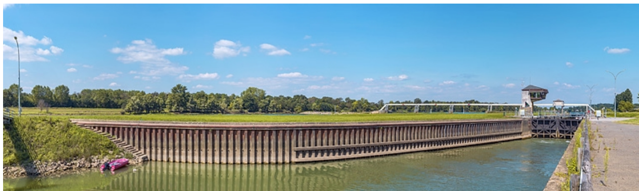
Murs-guides à l'aval du site d'écluse.
