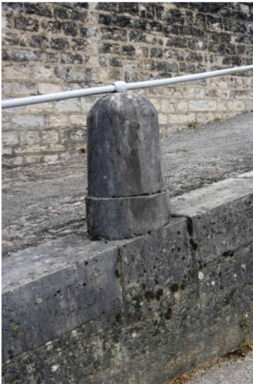
Borne monolithe de la rampe d'accès.
