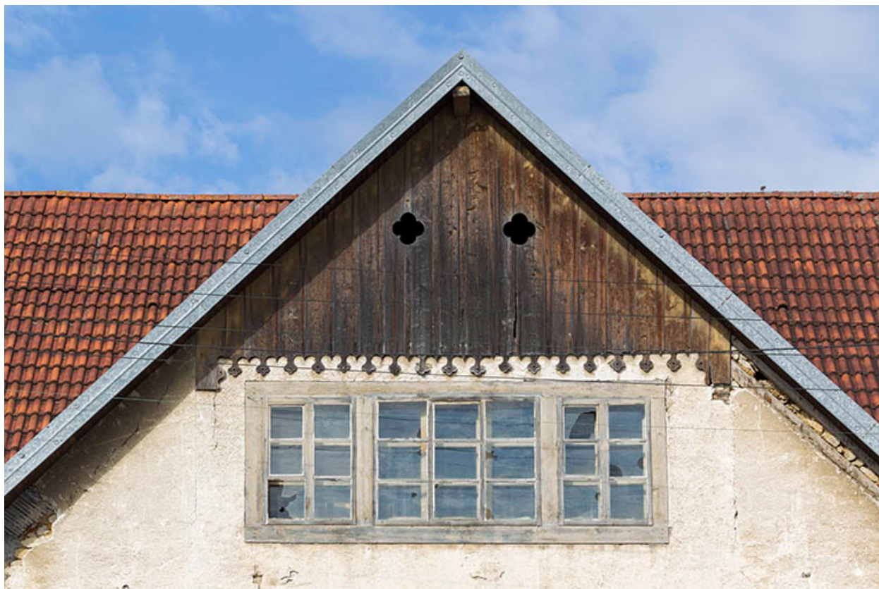
Façade antérieure : pignon.
