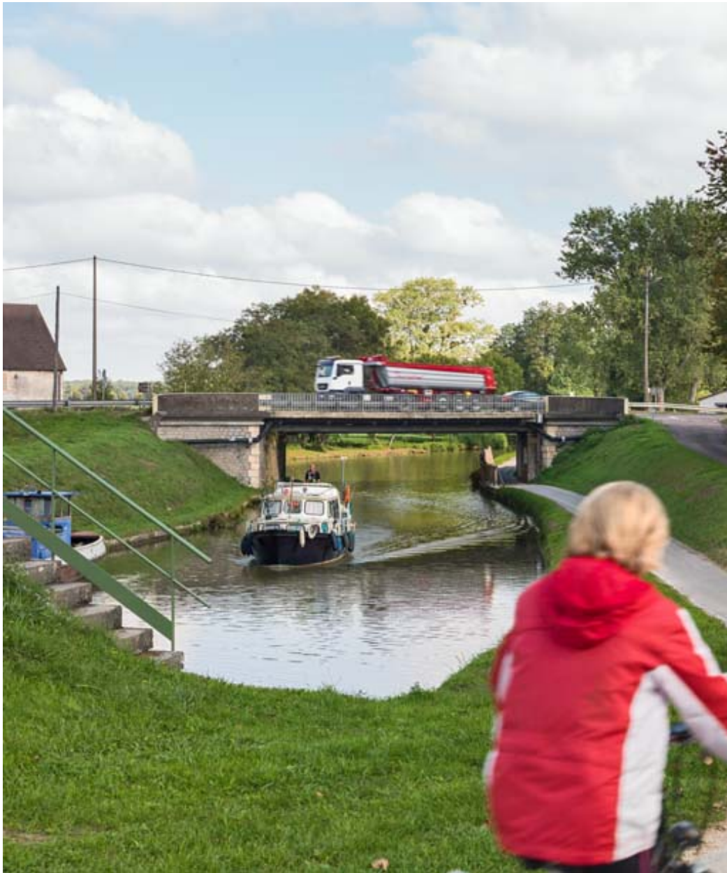
Vue d'ensemble du pont.
