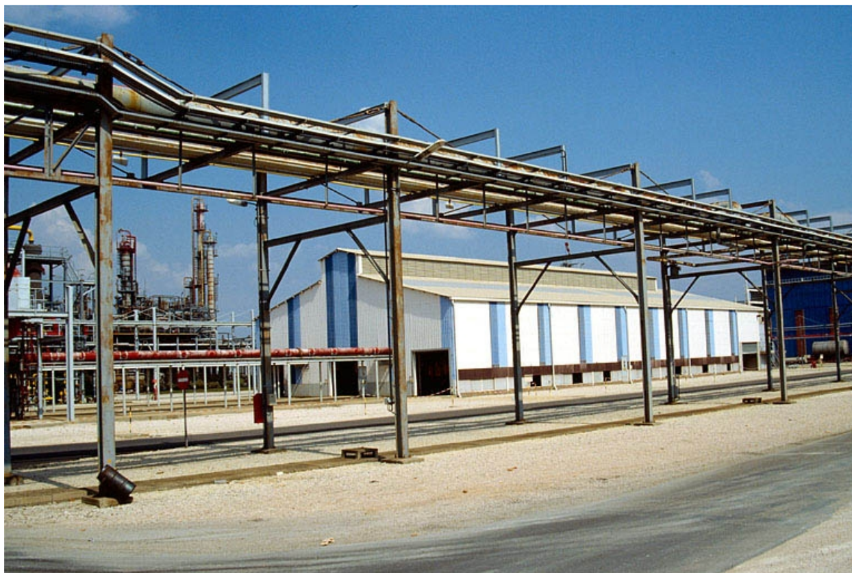
Salle 5 de l'usine d'électrolyse, vue de l'ouest.
