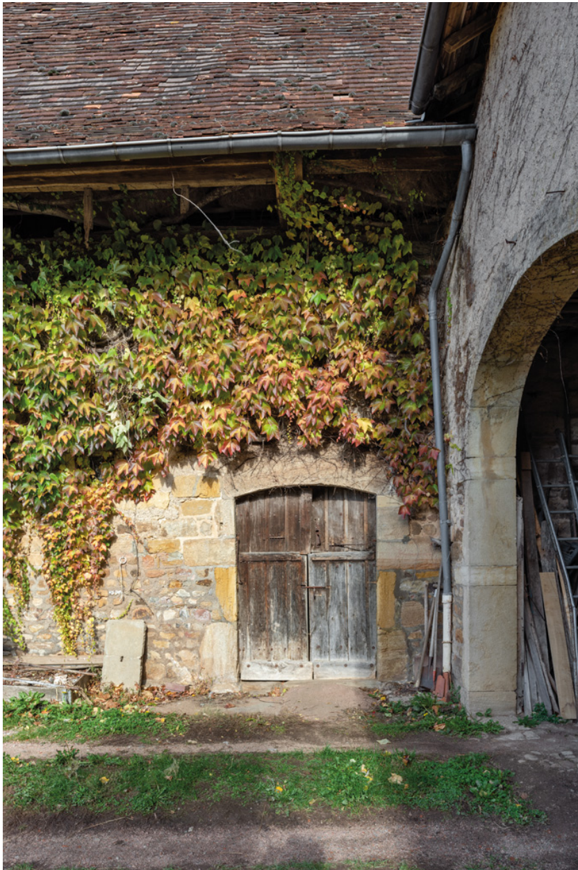
Porte d'étable du bâtiment nord.
