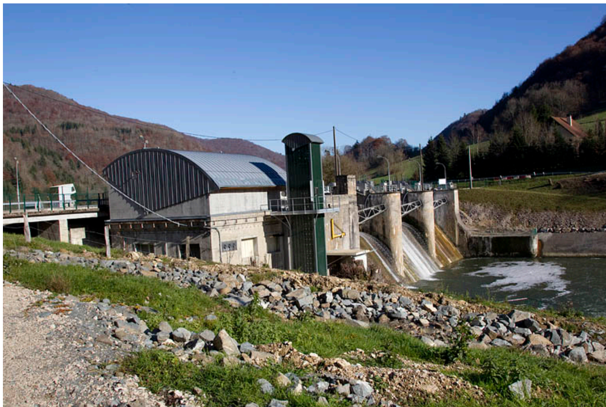
Centrale et ascenseur à poisson.
