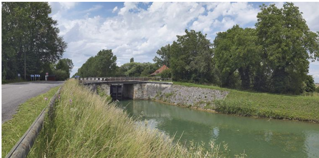
Pont vu d'aval.
