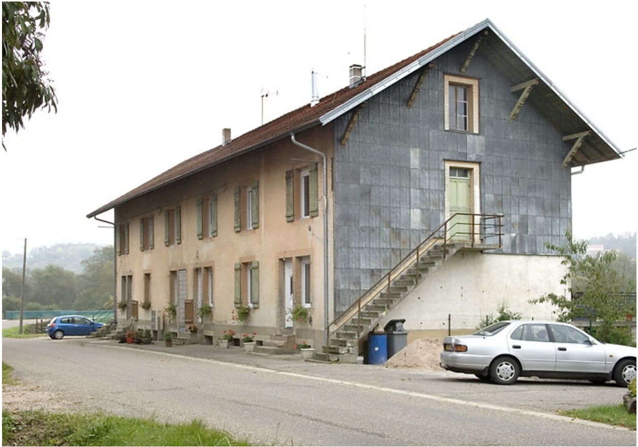
Logements d'ouvriers, bâtiment A, rue du Coney.
