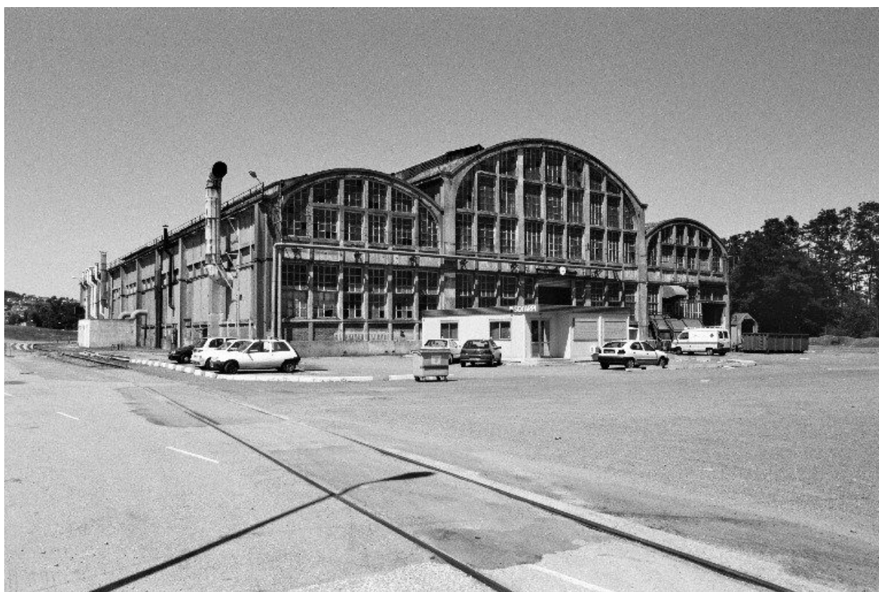
Annexe du CM 1 ou fonderie d'acier n°2, façade sud.
