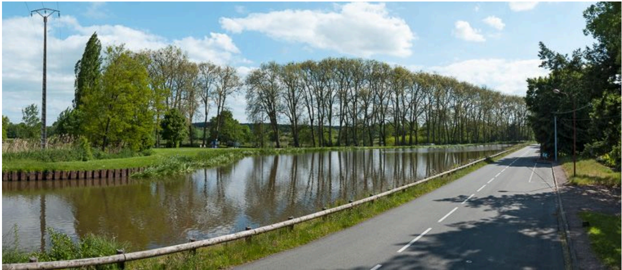
Vue d'ensemble d'amont du port de Ciry avec allée de platanes.
