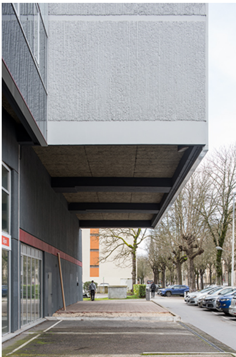
Façade nord-ouest, détail : avant-corps sud-ouest.
