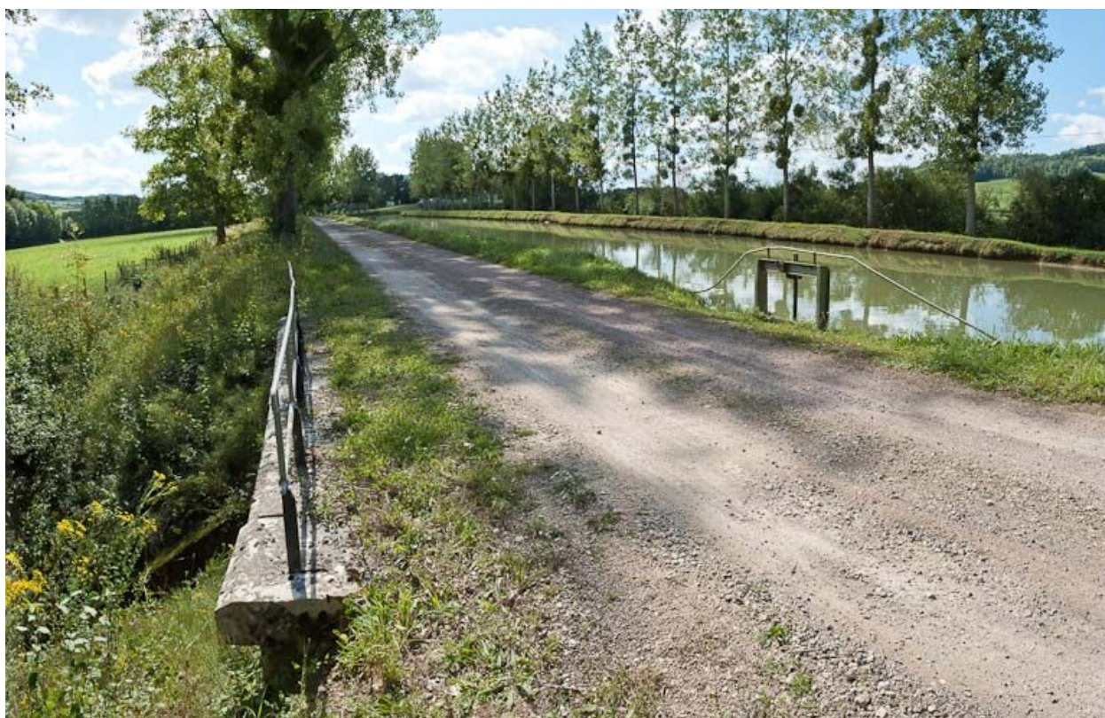
Vue du déversoir.
