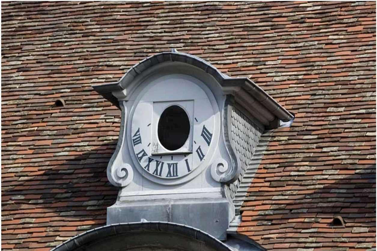
Détail d'une lucarne.
