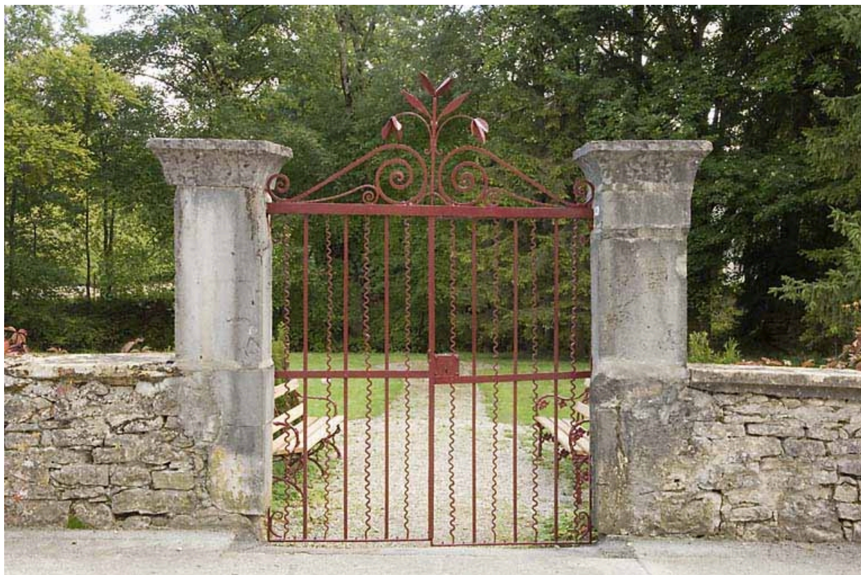
Grille du jardin, face au bâtiment 62-64 rue des Forges.
