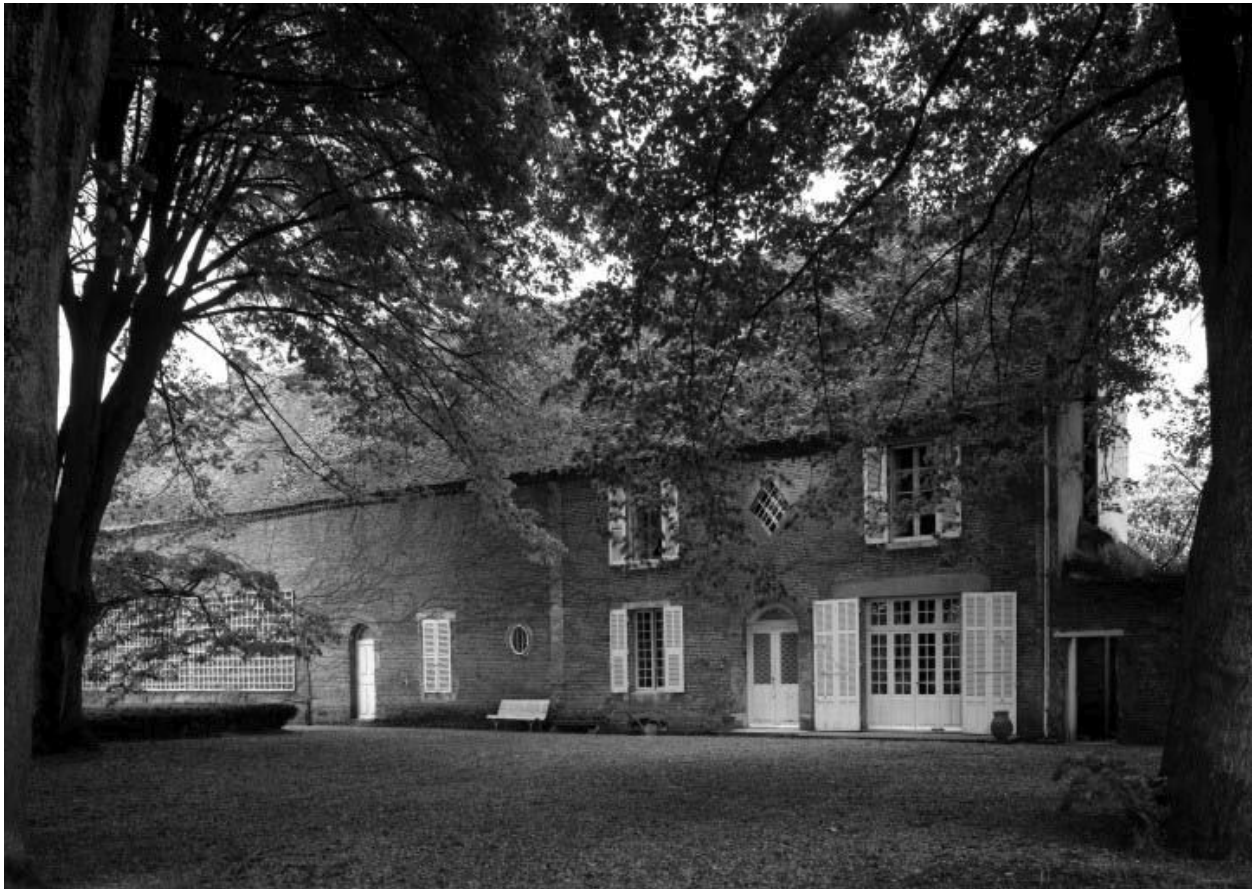
Bâtiment de l'ancien château, partie abritant le logis, élévation sur cour.
