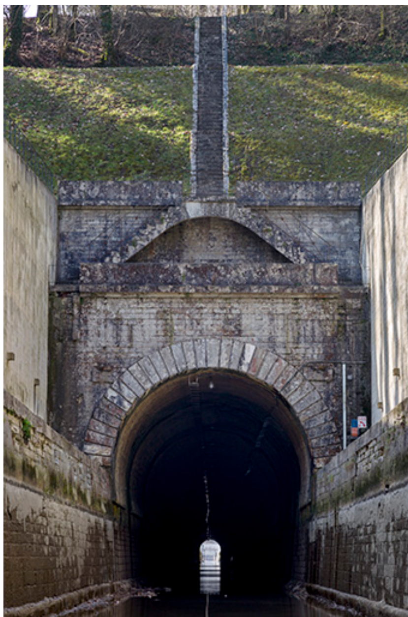
Entrée amont du souterrain.
