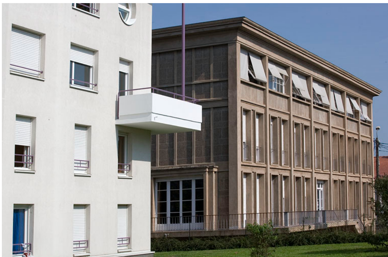
Vue d'ensemble, depuis le sud.
