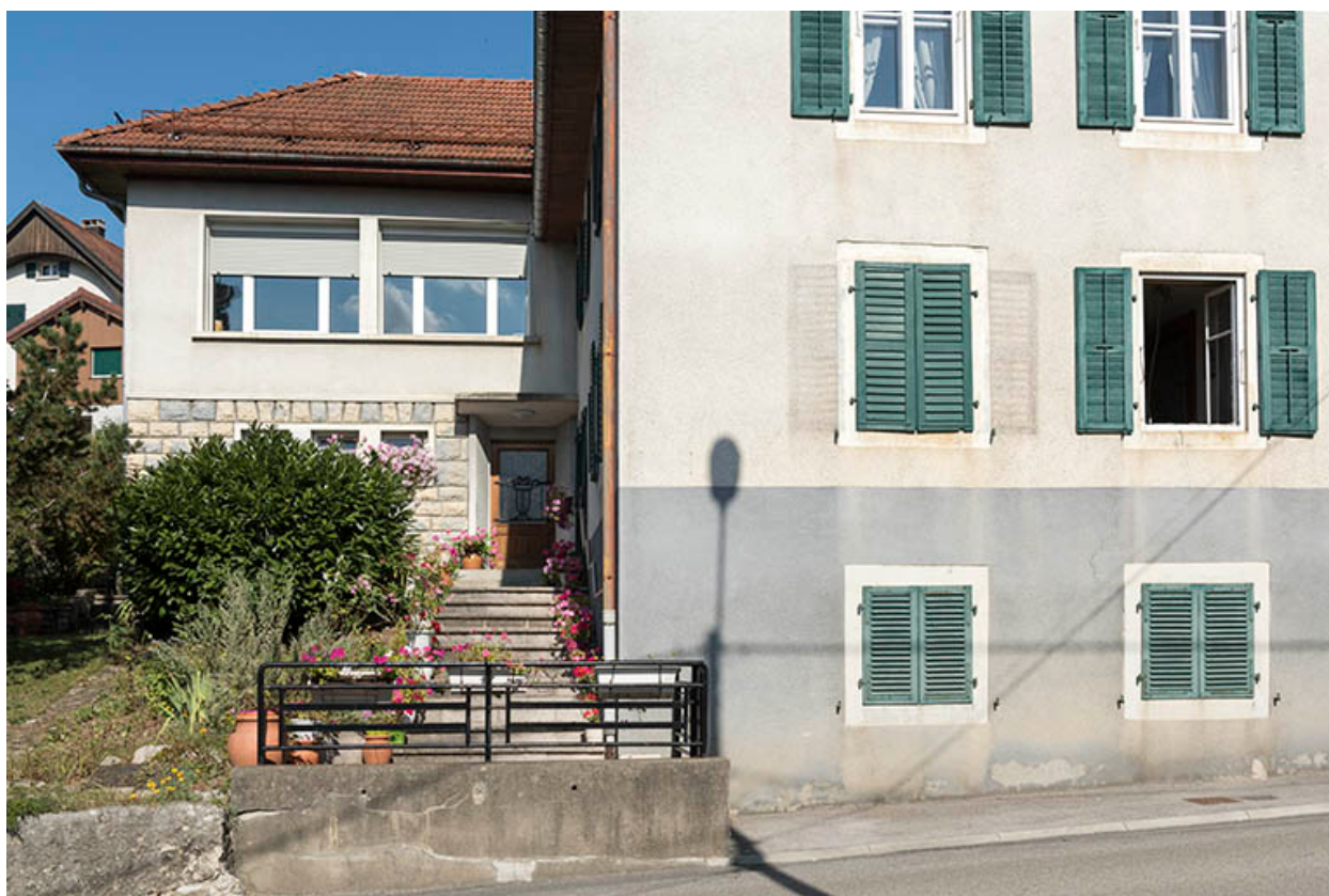
Façade antérieure de l'atelier de fabrication.
