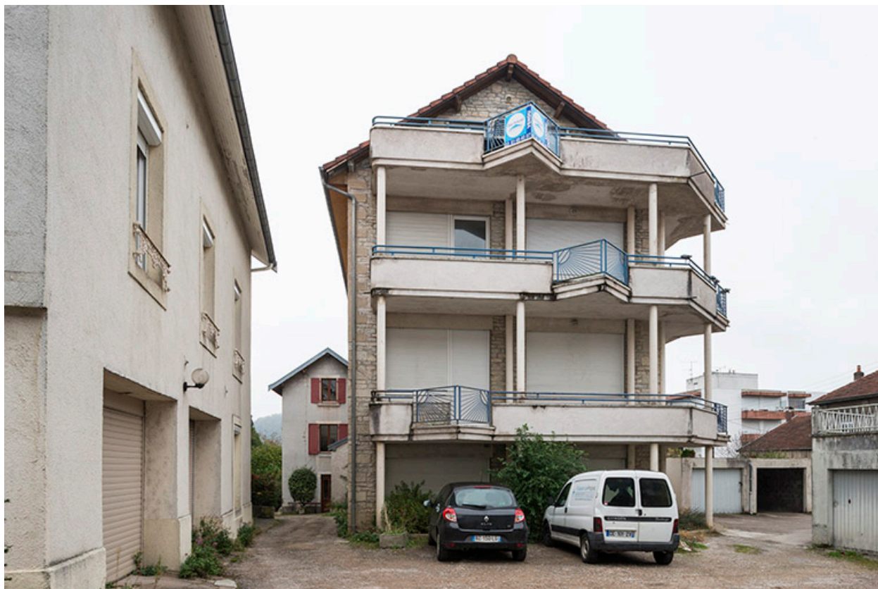
Mur-pignon nord de l'atelier.
