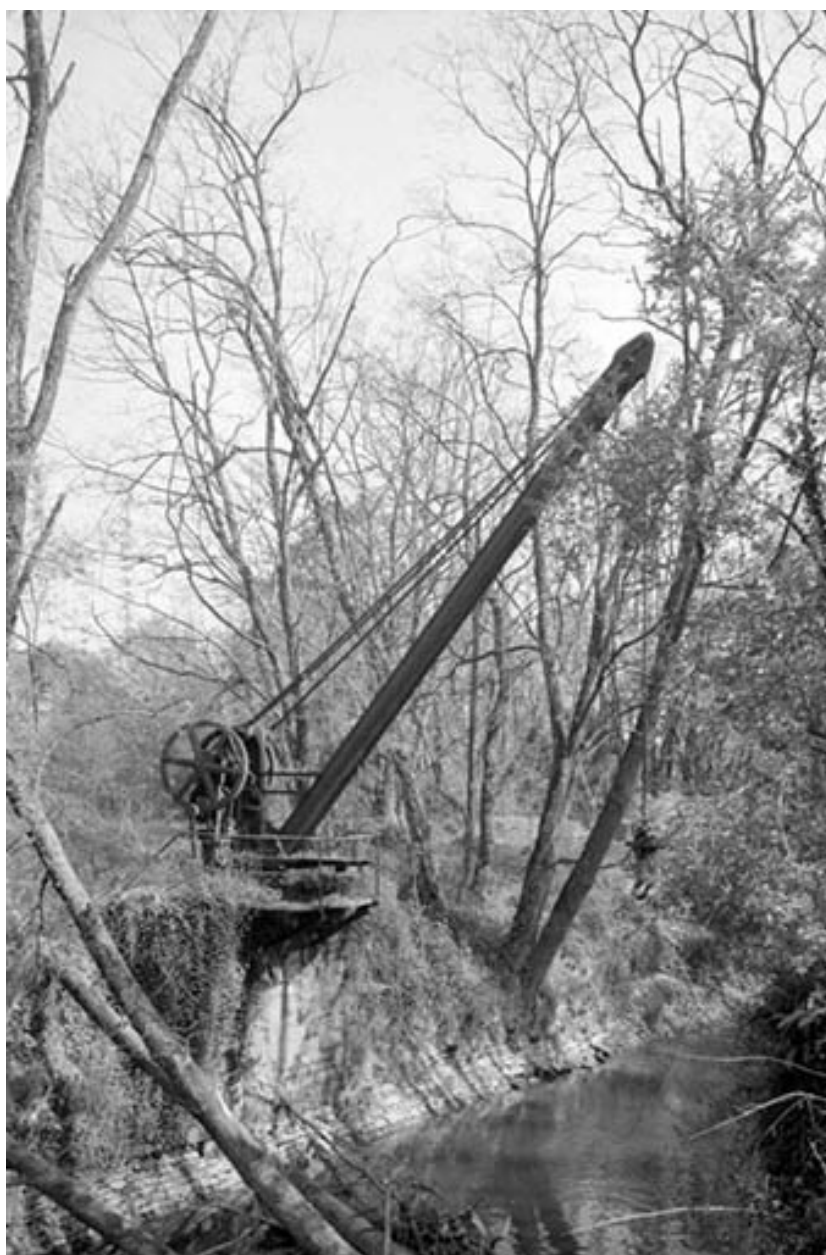
Forge Neuve. Le port : grue (M).
