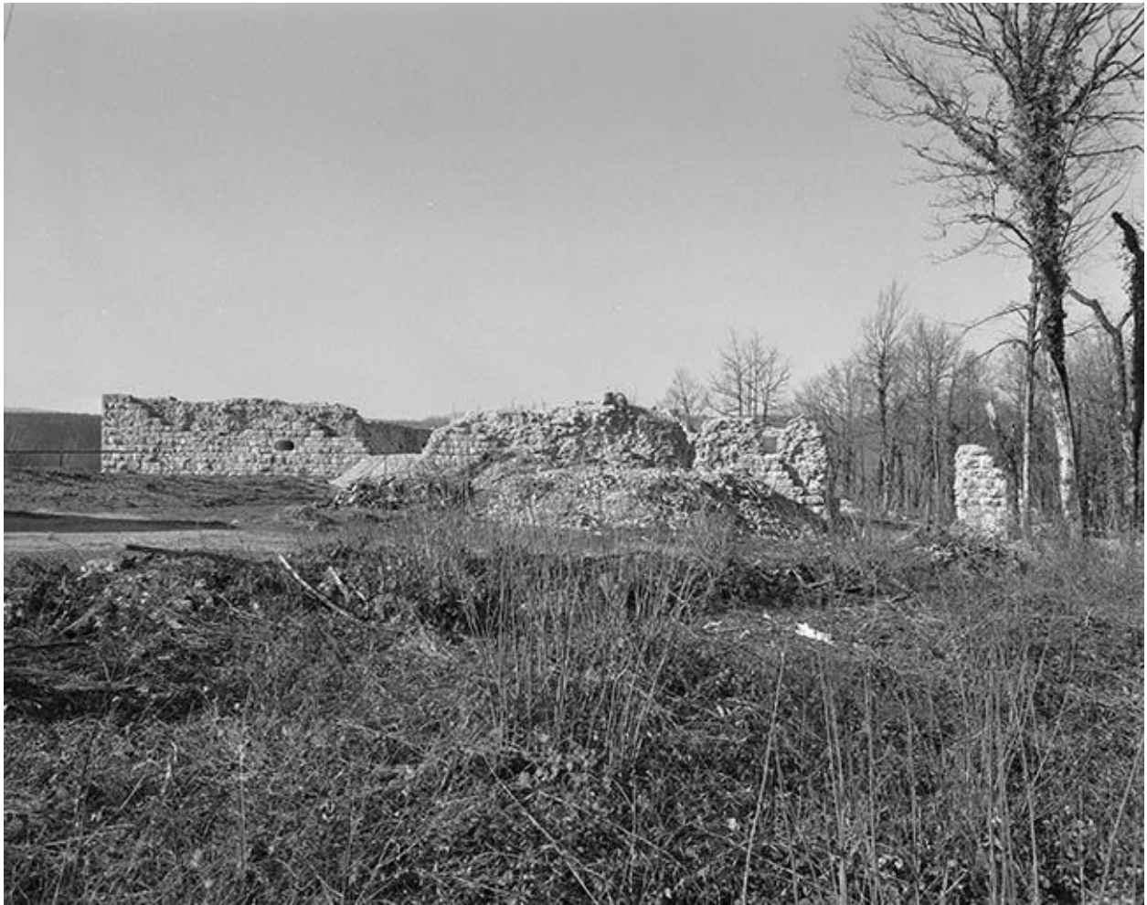
Vue générale du mur d'enceinte depuis l'est.
