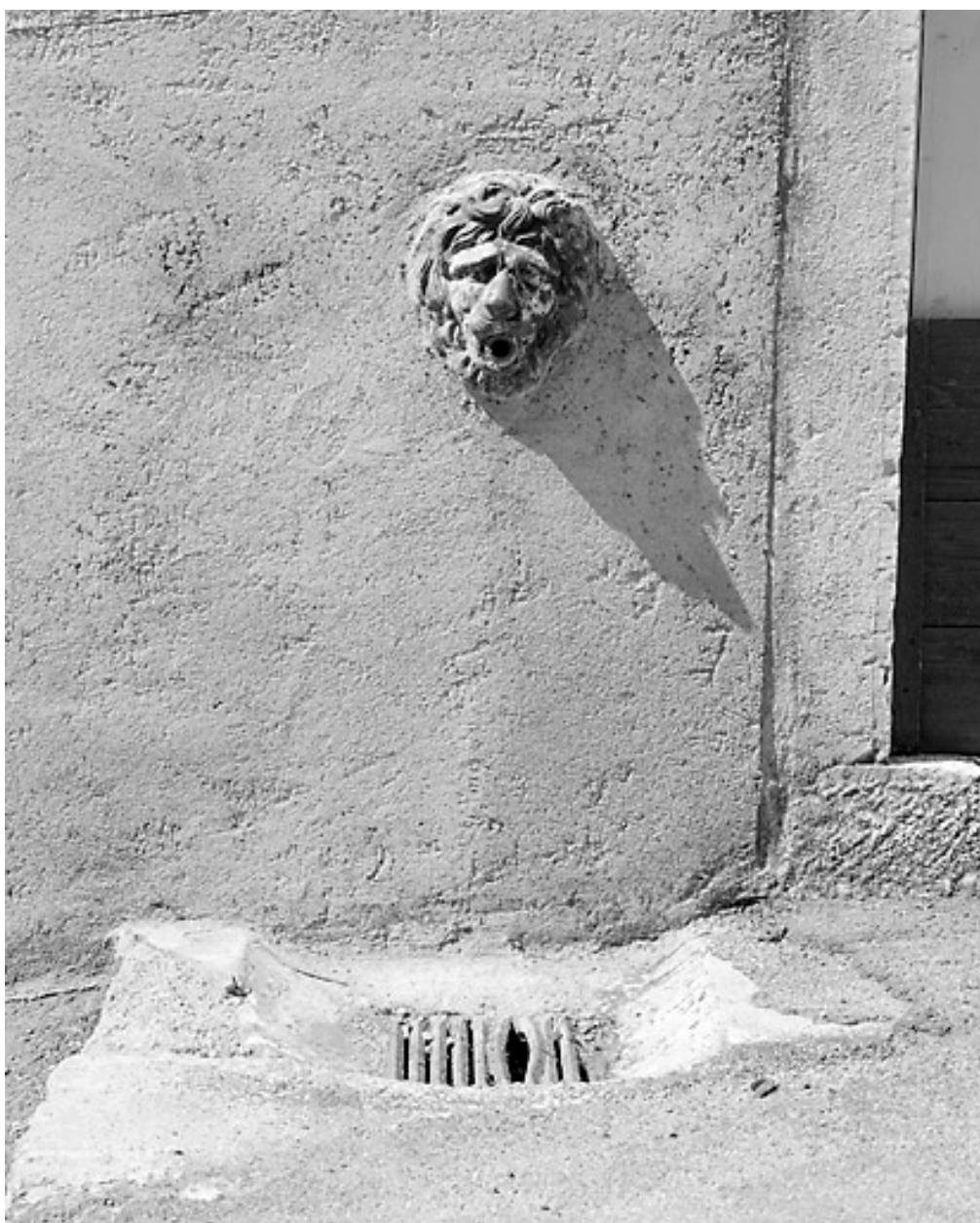
Bâtiment 3 rue Etienne Dolet : point d'eau.
