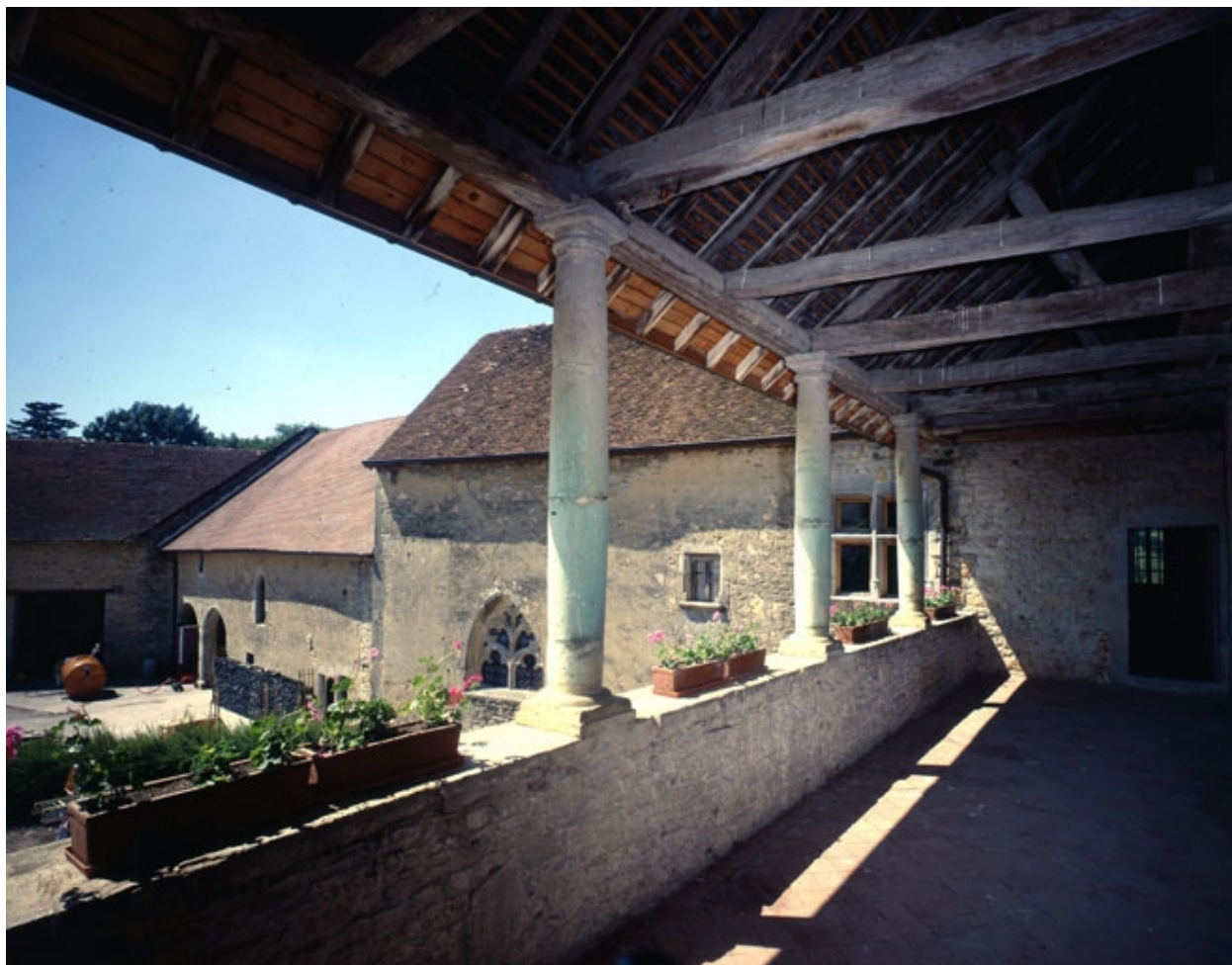
Galerie ouverte du premier étage.
