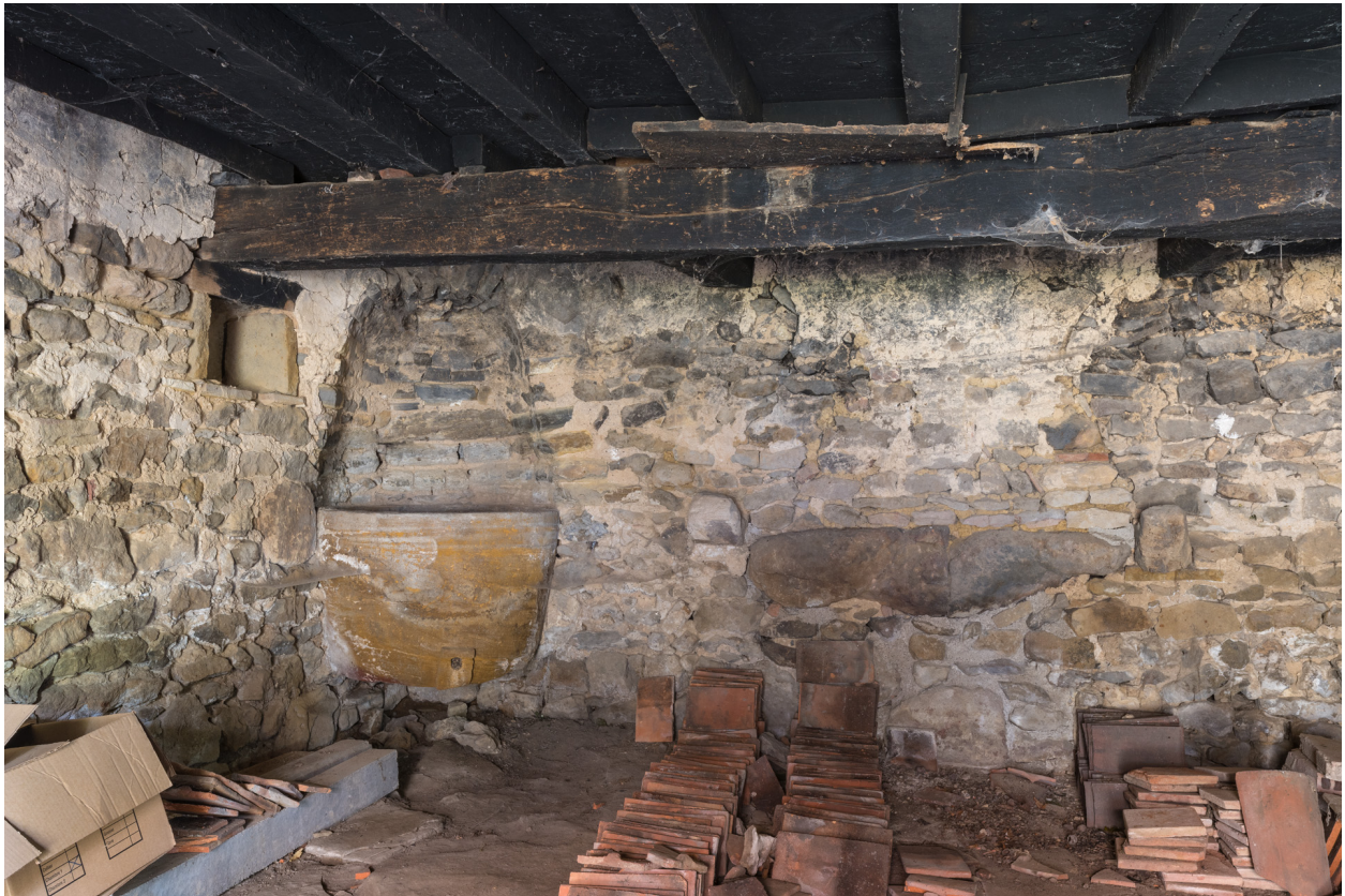
Vue intérieure de la dépendance. Face au mur postérieur sud.
