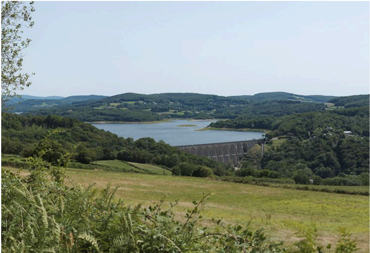
Vue de l'ensemble du barrage et du réservoir de Pannecière.
